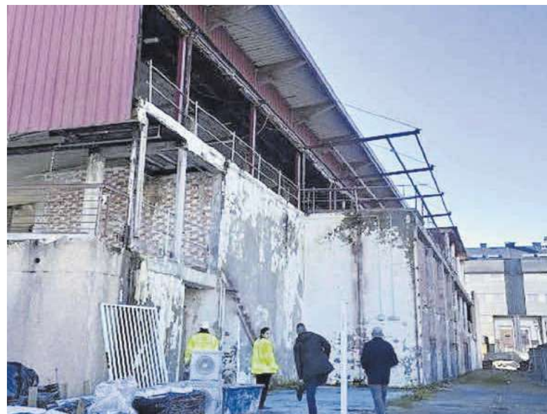
Técnicos de la constructora, ayer, en la piscina.
