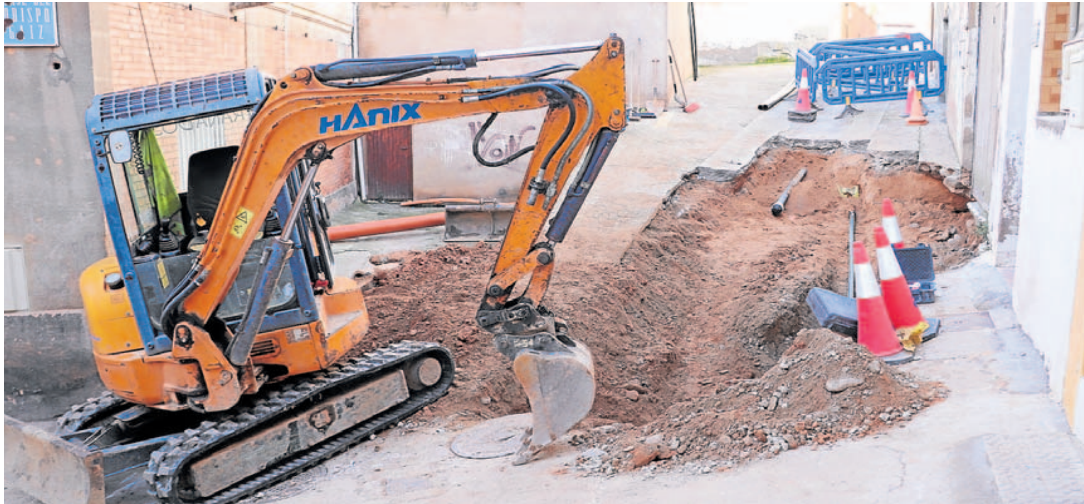
Máquinas y operarios ya se han puesto a la labor de recuperar el estado de la calle Rosales con Pasaje Arzobispo Argaiz. E. P.
